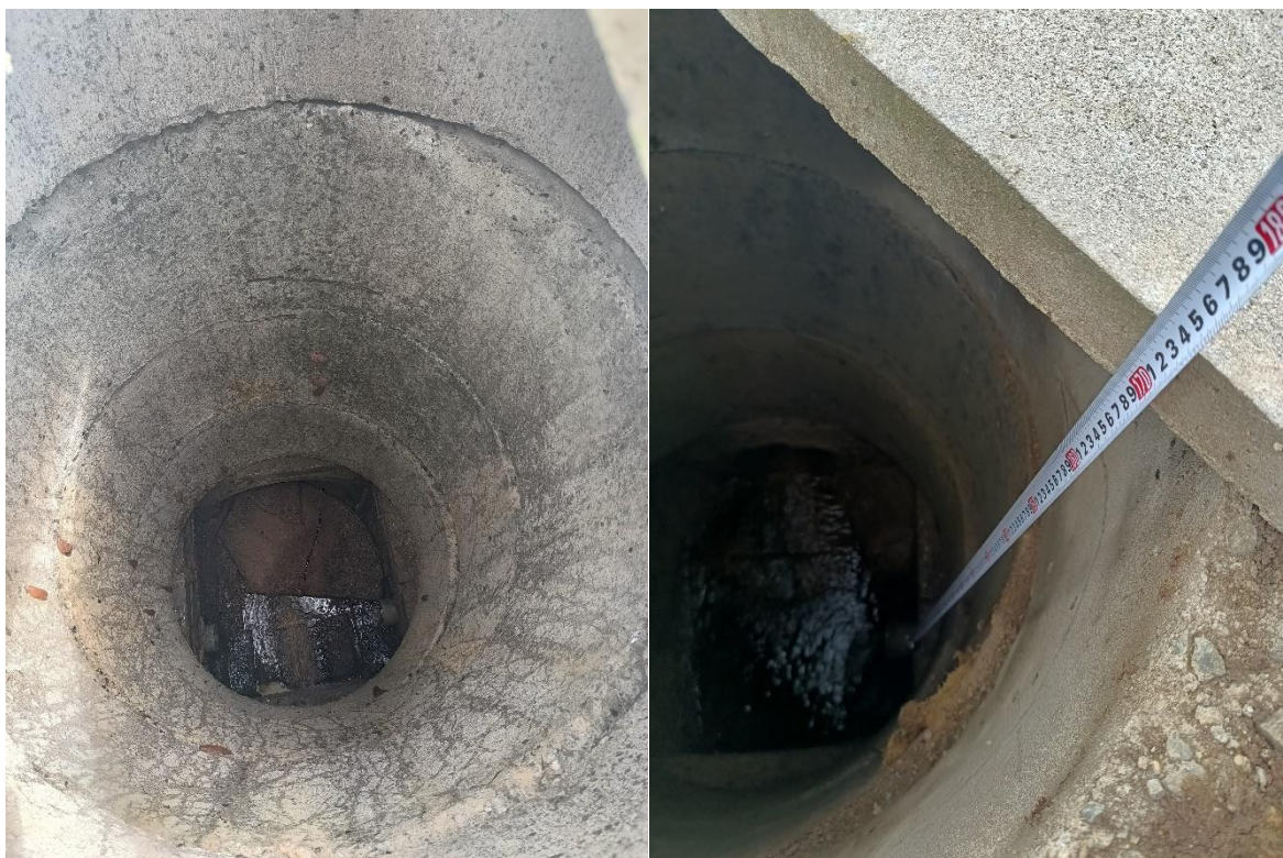
Šachta s původním poklopem na dně, viditelné dva přítoky (vlevo), měření přítoku (vpravo)
