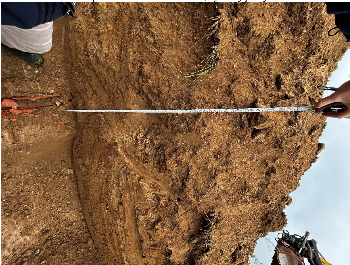
Obr. Kopaná sonda u skruže č. 4 – odhalení svodného drénu v pravobřeží
